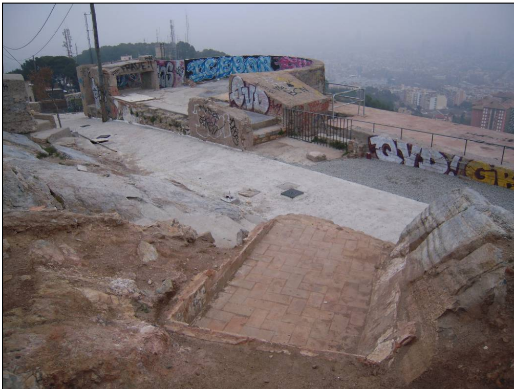
Foto 27: Vista general des del lloc de comandament, amb el camí d'accés pavimentat.
