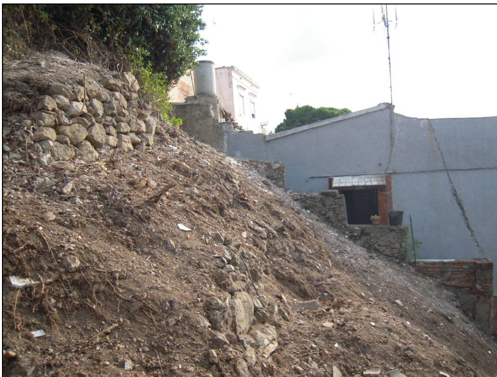
Foto 16: Imatge de l'acumulació de la runa al sector meridional.
