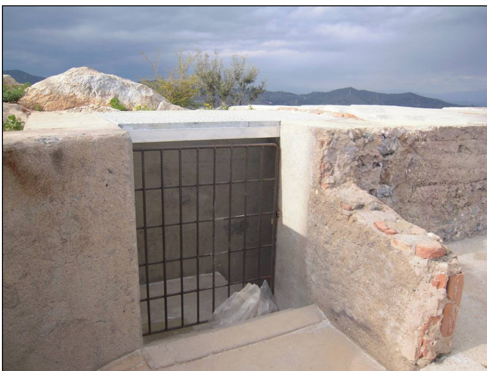
Foto 30: Col·locació d'una porta per a la protecció dels espais interiors de la bateria antiaèria.
