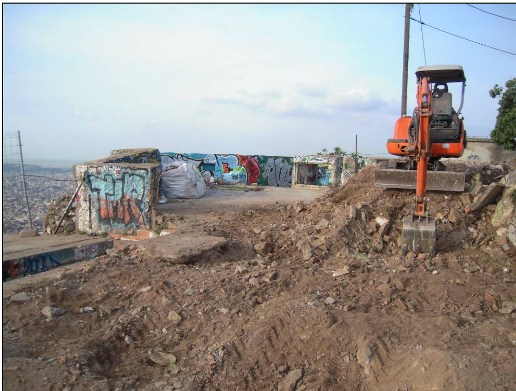
Foto 15: Treballs mecànics de retirada de la runa al punt central de la bateria antiaèria.
