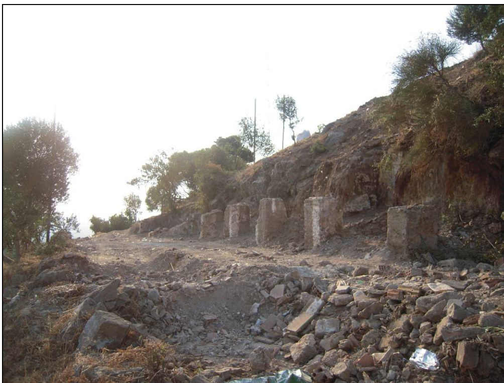
Foto 9: Treballs de retirada de la runa al sector dels barracons militars. Es visible els pilars que subjectaven els pavellons.
