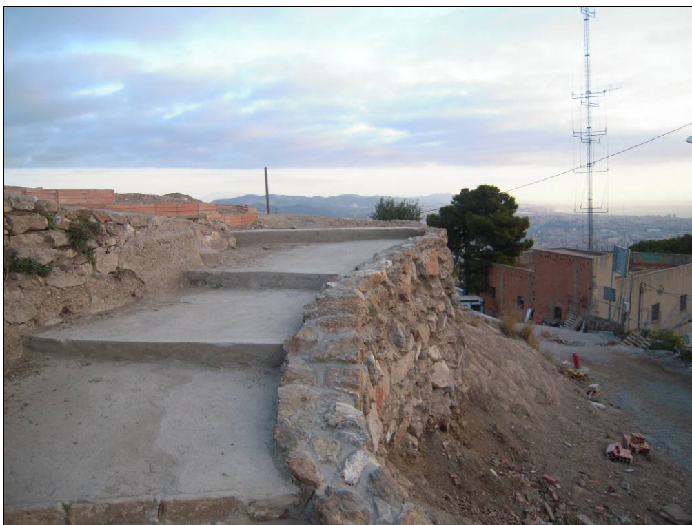
Foto 26: Imatge de detall dels treballs de consolidació d'un accés creat pels barraquistes.
