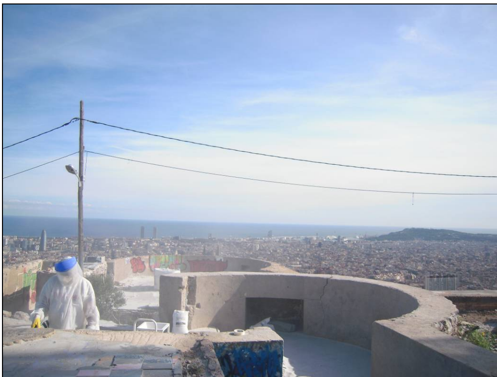
Foto 28: Imatge dels treballs de restauració en l'eliminació dels grafitis de les estructures militars de la bateria antiaèria.
