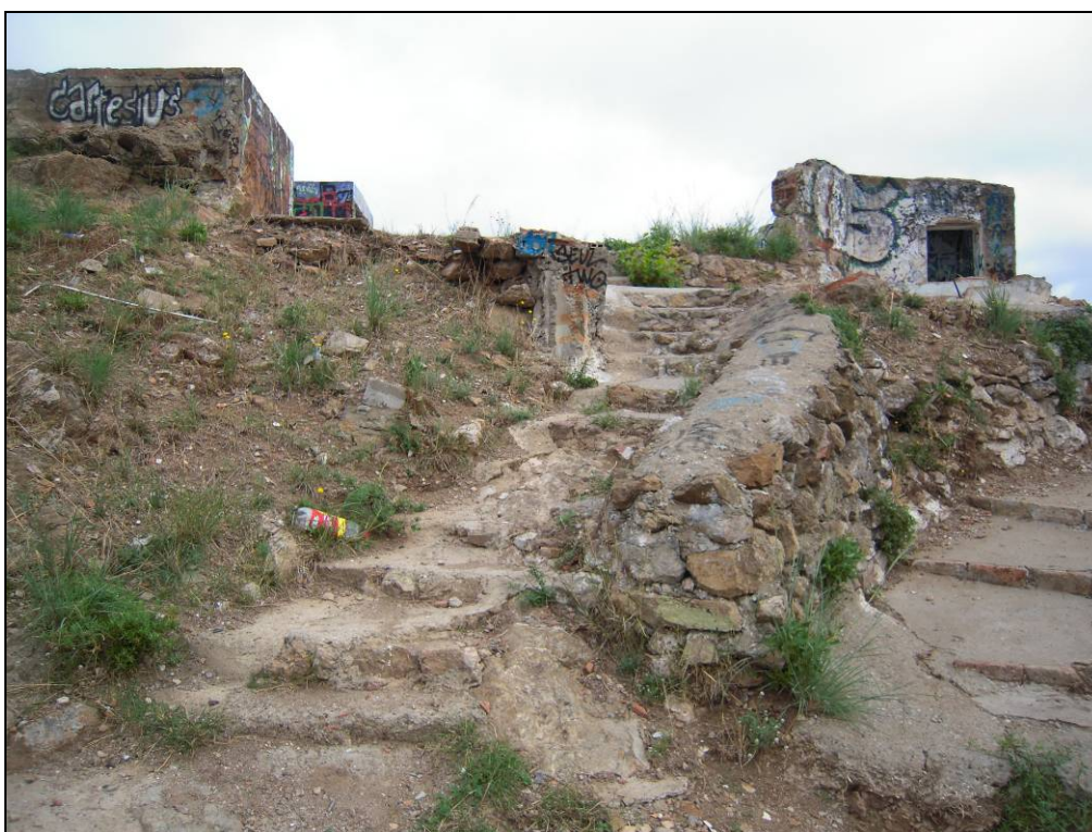
Foto 2: Estat d'un dels accessos a la plataforma superior abans de la neteja superficial.
