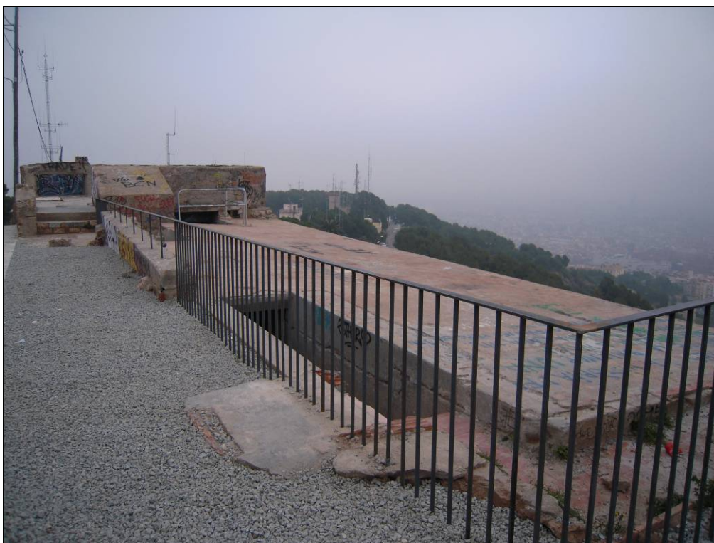
Foto 33: Protecció o tanca construïda davant el perill existent, al sector central de la bateria antiaèria.
