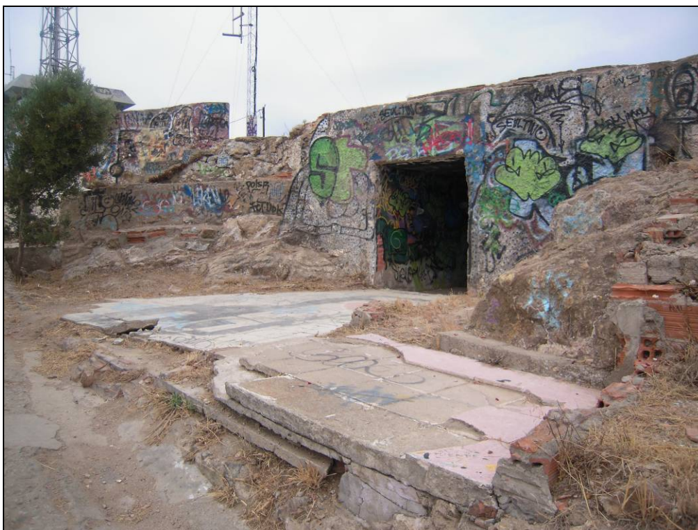
Foto 23: Recuperació de la geometria del nucli de barraques relacionada amb les estructures defensives militars.
